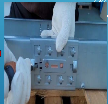
3 . 케이블트레이와 무볼트조인트 체결
